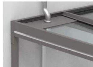
Passage du tuyau de descente
